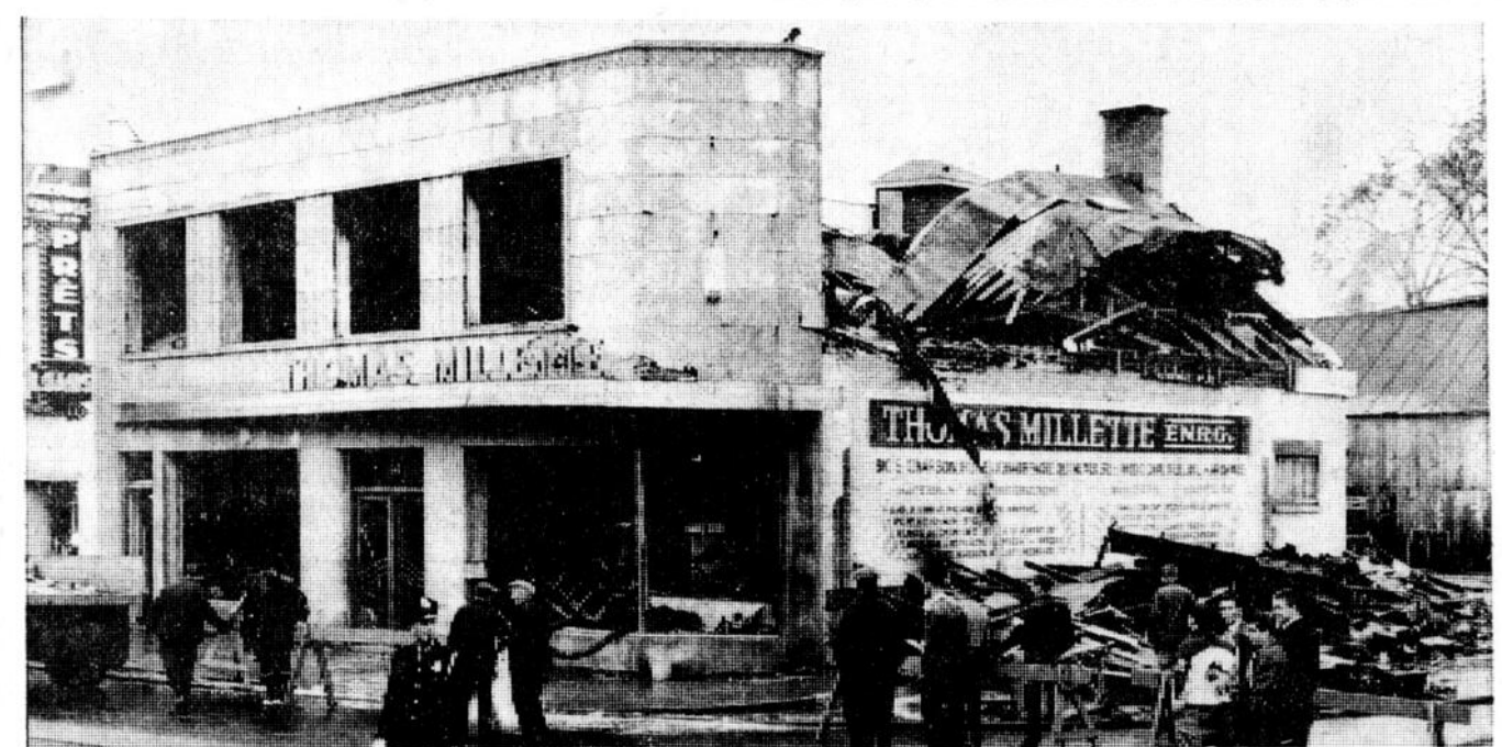
VOILA CE QUI RESTE DE LA QUINCAILLERIE THOMAS MILLETTE ENGR. qu'un incendie a ravagé dans la nuit de jeudi à vendredi dernier. Les bureaux de la compagnie de finance Lucerne, situés au deuxième étage, ont été également détruits par les flammes. Les pompiers durent accomplir leur travail malgré les explosions entraînées par la combustion de la peinture du naphthé et de munitions entreposées au sous-sol. Leur savoir-faire a empêché que des établissements avoisinants, notamment un magasin de lingerie pour dames, le théâtre Avalon et le salon funéraire Jos. Pitre Engr., soient également rasés par les flammes sans cesse activées par des produits très inflammables. (Photo R.-L. Gendron)
