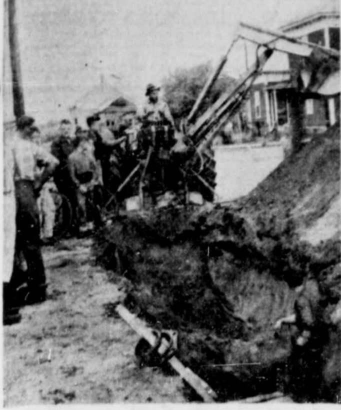
LES TRAVAUX relatifs à l'aménagement d'un nouveau système d'accès à St-Georges-de-Champlain ont débuté le 20 juin sur la rue Garrier, et déjà on a creusé une tranchée de six pieds et demi de profondeur, sur une distance de cinq cents pieds. On voit ci-haut une chargeuse de Robitaille et Velleite, de St-Tite, à l'œuvre.
