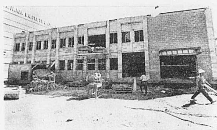
Les rénovations vont bon train et on peut déjà se faire une idée de l'apparence du complexe où seront installés les studios de Radio-Québec.
